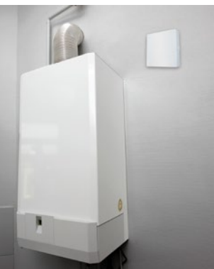
Area bagno/locale caldaia
