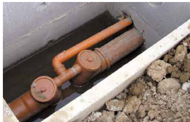
Esempio di installazione di sifoni AN in un pozzetto di cemento con ventilazione secondaria
