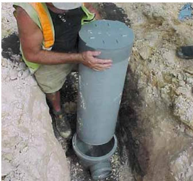
*Esempio di installazione con pozzetti fognatura in PVC REDI*
