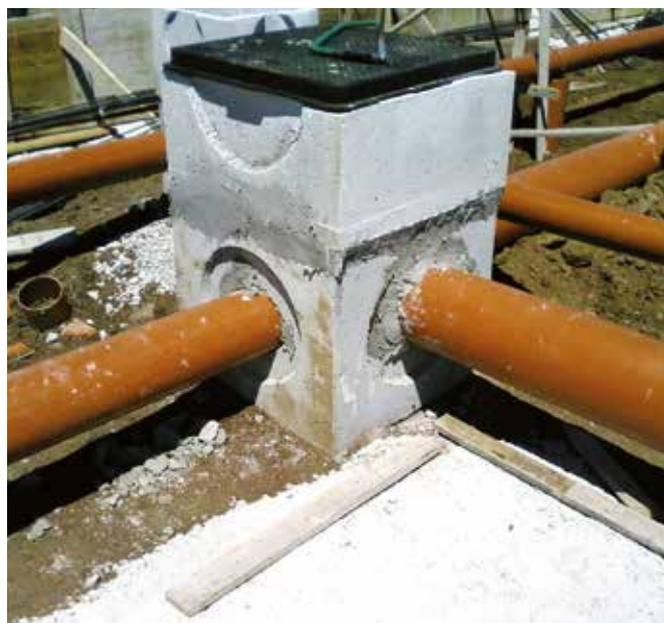
*Esempio di installazione con pozzetti e prolunge in cemento*
