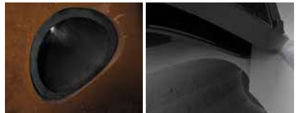
Vista dall'interno di una condotta in gres: La guarnizione non sporge all'interno del tubo
