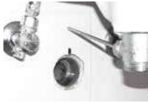
1) smontaggio del sifone esistente
