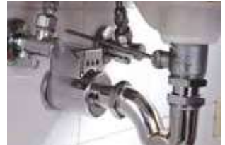
6) montaggio del sifone e armonia estetica finale
