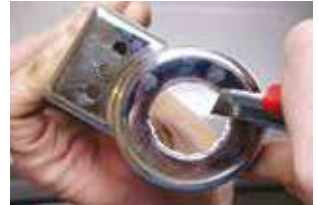
4) adattamento della rosetta cromata (d. 1"1/4 e 1"1/2 prefondato)
